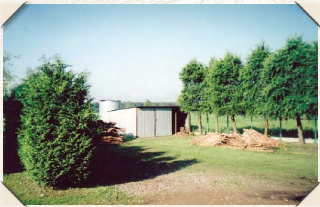
Magazyn oraz silos na zboże zlokalizowane obok Domu Myśliwca w Bojszowach, wykonane społecznie przez myśliwych K. Ł. „Przepiórka” Bojszowy.
